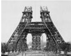
(15 mei 1888: De montage van de pilaren boven de eerste verdieping)
