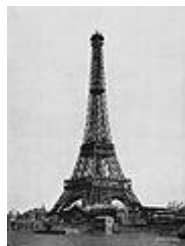
(15 maart 1889: De montage van de derde verdieping)
