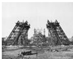
(7 december 1887: De montage van een steunpilaar voor de bouw van de eerste verdieping)
