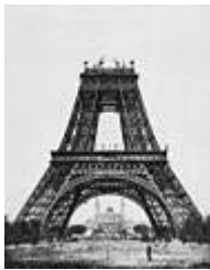
(21 augustus 1888: De bouw van de tweede verdieping)
