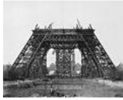
(20 maart 1888: Constructie van de horizontale balken voor de middelste steigers)
